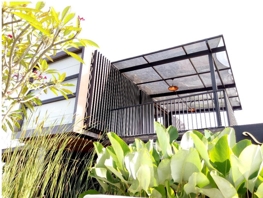
Foto 9. Areal Teras atas beratap Solarlite
