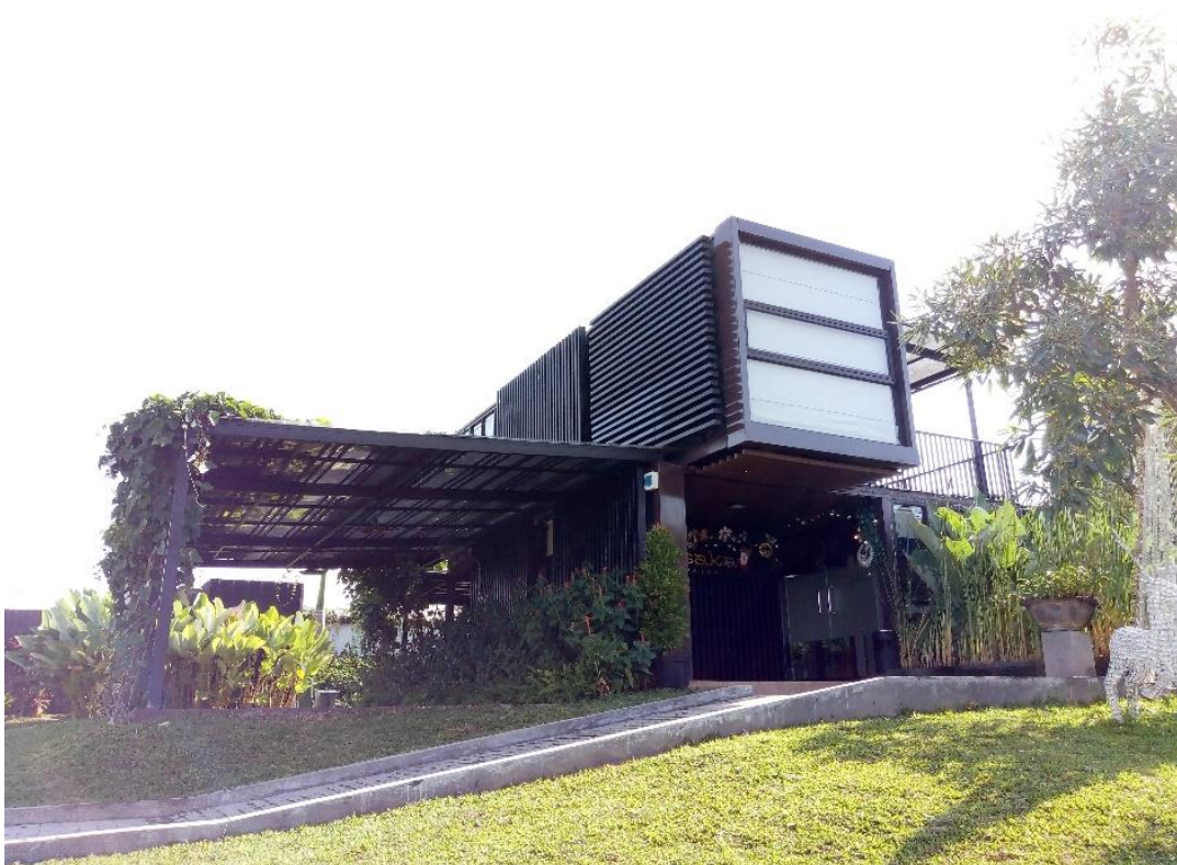
Foto 2. Bangunan Kontainer Kantor Vasaka ( Pintu Masuk )
