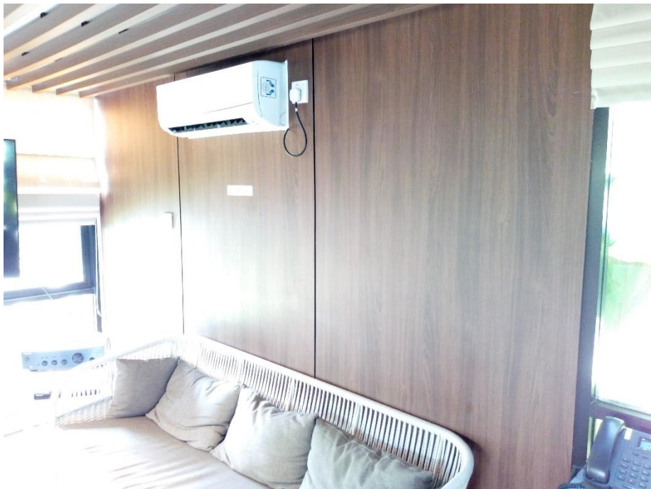
Foto 16. Dinding dengan peredam Busa dan AC Split yang membuat ruangan cukup sejuk
