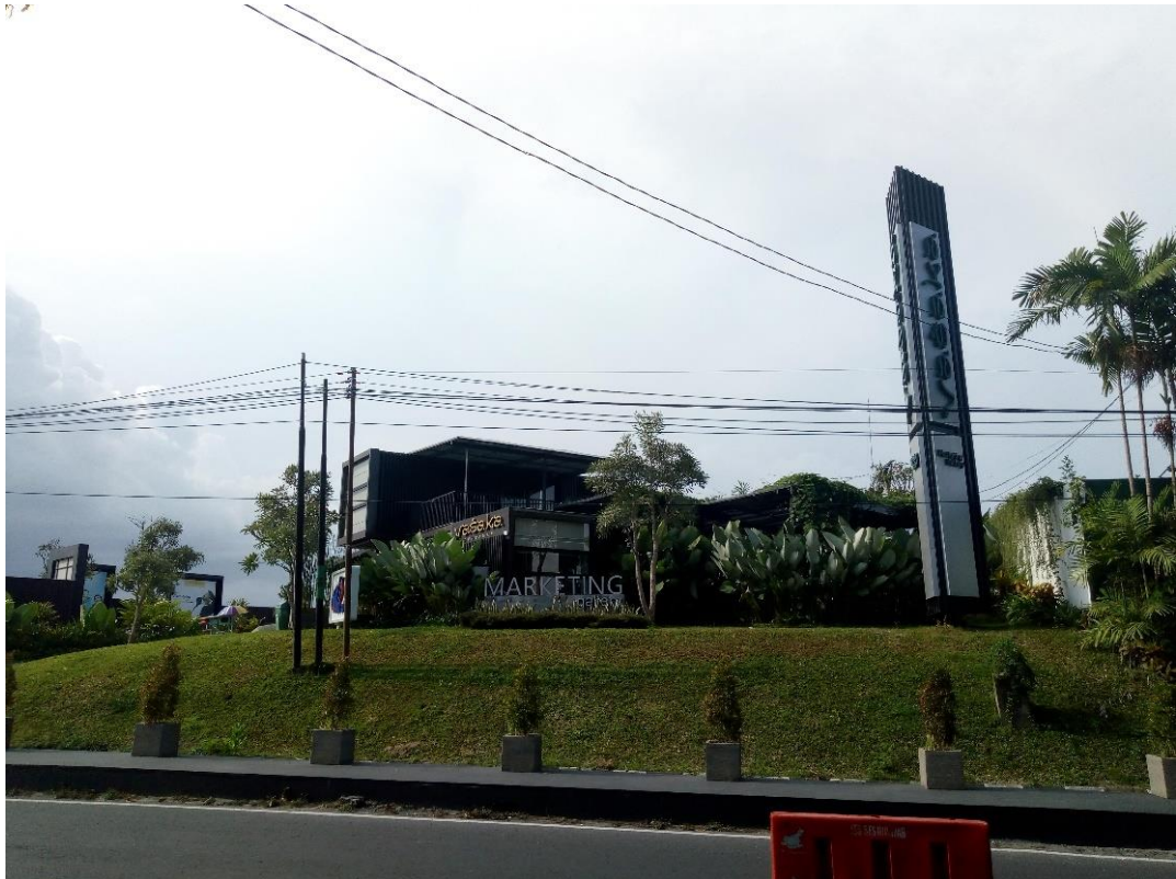
Foto 1. Bangunan Kontainer Kantor Vasaka dari arah jalan.
