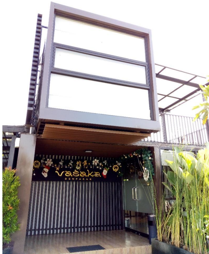
Foto 8. Areal Main Gate Kantor, Bukaan Jendela besar serta pintu utama untuk pencahayaan alami
